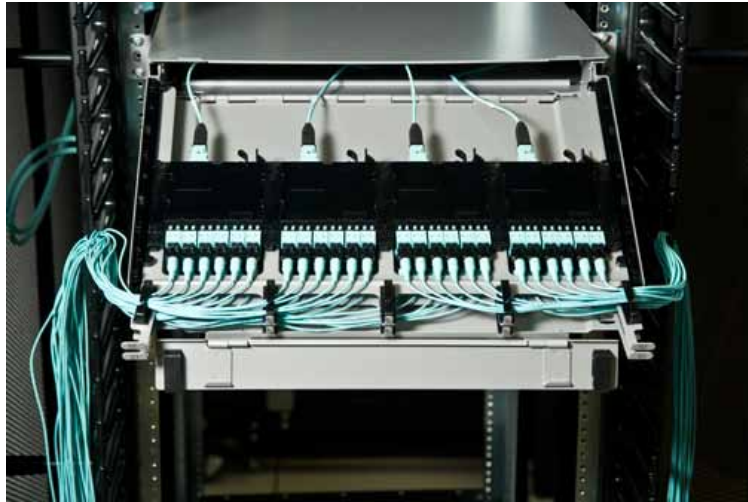
图 9 – 1U 光纤配线架
