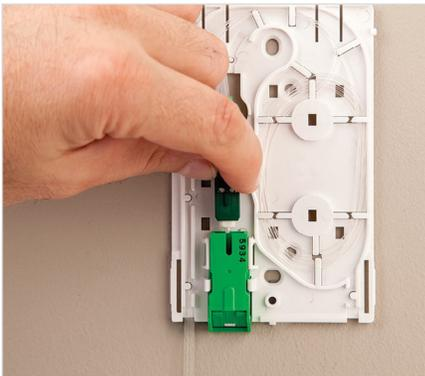
Conectando la Fibra de 900 µm dentro de la Placa de Pared de Bajo Perfil
