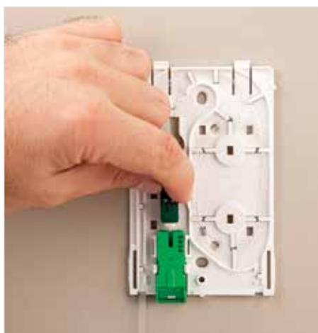
Anschluss einer 900-µm-Glasfaserfestader im Wandmontagegehäuse
