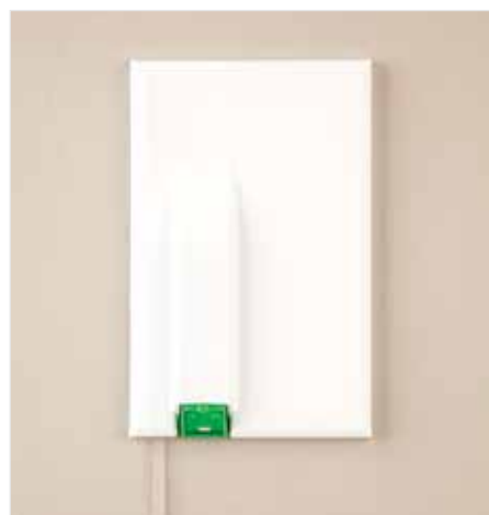
Fertige Installation der TAE
