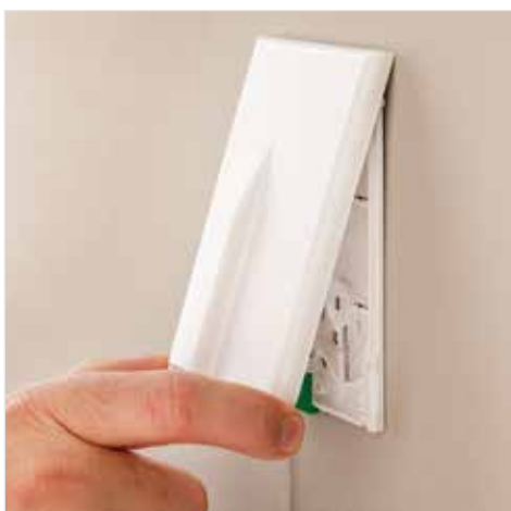
Aufsetzen der Gehäuseabdeckung
