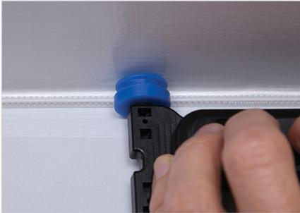
Instalación de Clear Track Hallway Fiber Pathway con la herramienta de instalación para pasillos
