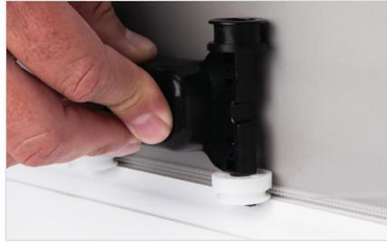
Fibra transparente de 900 µm na Infraestrutura de Passagem de Fibra Óptica em Residências com a ferramenta de instalação
