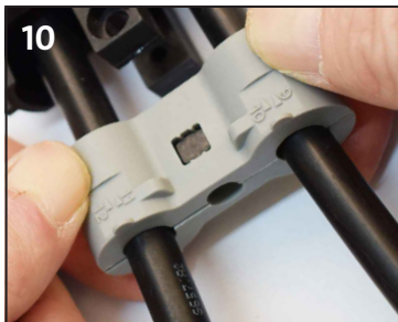
10 place and clip the spacers / placer et clipper les entretoises
