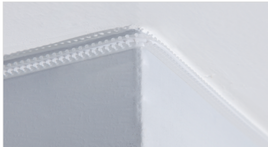
Chemin de câble fibre optique pour couloir Clear Track installé autour de l'angle extérieur
