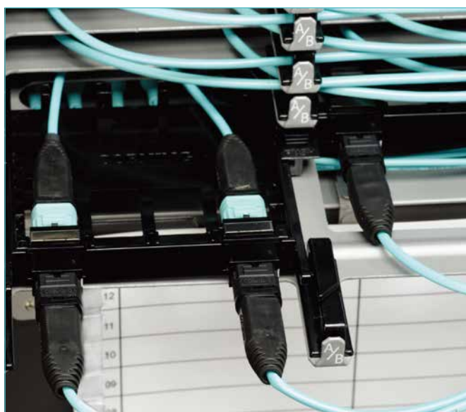
EDGE 解决方案MTP连接器面板，装载于配线箱中
