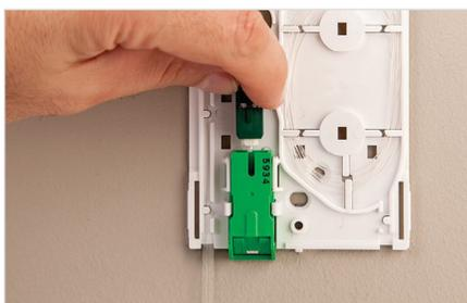
Conectando a rota da fibra de 900 µm dentro do painel de parede de perfil baixo
