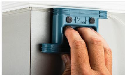
Instalação de Hallway Fiber Pathway com a ferramenta de instalação universal Clear Track Hallway
