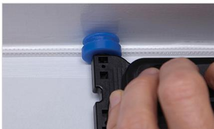
Instalação da Infraestrutura Clear Track para Passagem de Fibra Óptica em Corredores com a ferramenta de instalação em corredores
