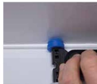
Installation du micromodule 12 fibres sur le chemin de câble fibre optique pour couloir Clear Track
