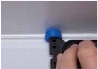
Installation des Clear Track-12-Faser-Mikromoduls im Clear Track-Glasfaserkanal für den Flurbereich
