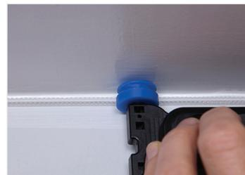
Installation des Clear Track Innenkabel im Clear Track-Miniaturkabelkanal Hallway
