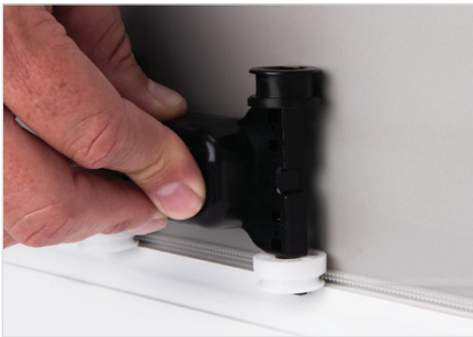
Fibra transparente de 900 µm dentro del Clear Track ILU Fiber Pathway con la herramienta de instalación ILU
