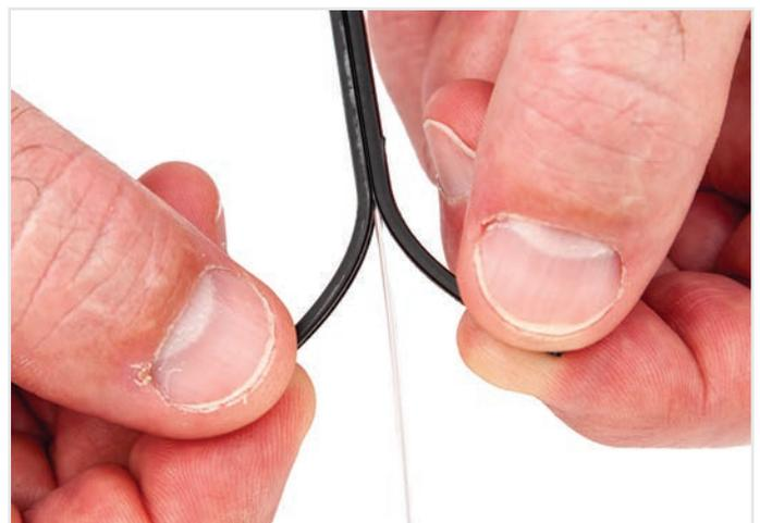
Figure 5. Le câble de dérivation dénudé sans outil pour accéder à la fibre transparente.
