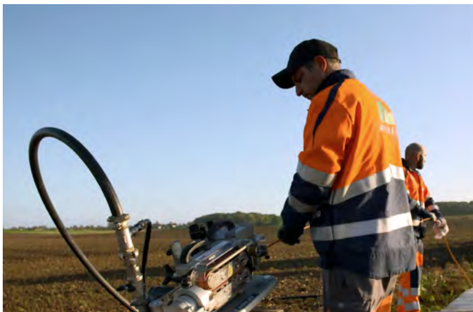
MiniXtend®光缆可通过气吹设备布放到微管中
